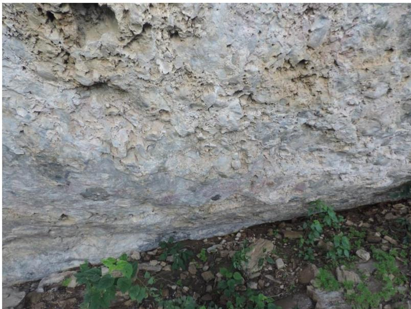
Figura 91 – Dissolução do metaconglomerado carbonático no Geossítio Mirador. Além de afetar a rocha, torna-se um problema para a conservação dos registros rupestres encontrados no local. Foto: Matheus Lisboa.
