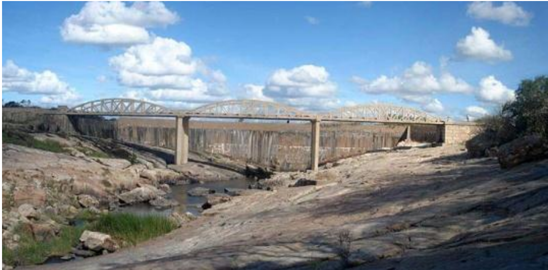
Figura 53- Ponte Pedra Lavrada sobre o Rio Seridó
